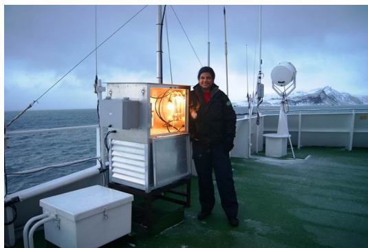
Parte dos equipamentos do projeto AURORA instalados no Tijupá do NPo Almirante Maximiano para a coleta de aerossóis.
